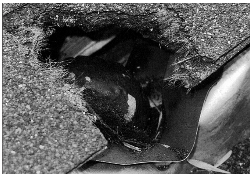
Okaz Kolkebecka 1006 g na miejscu w rynnę. Fot. Joseph Kolkebeck.
