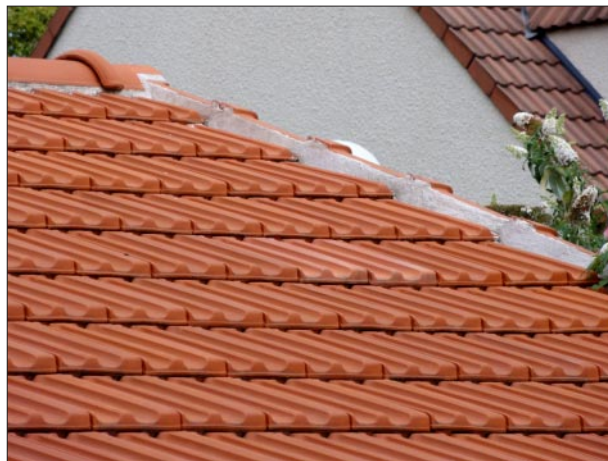
Te dwie jaśniejsze dachówki zostały szybko włożone na miejsce rozbitych (z powodu zbliżającego się deszczu) po tym jak pan E. zauważył dziurę w dachu. © Pierre-Marie Pelé, meteor-center.com
